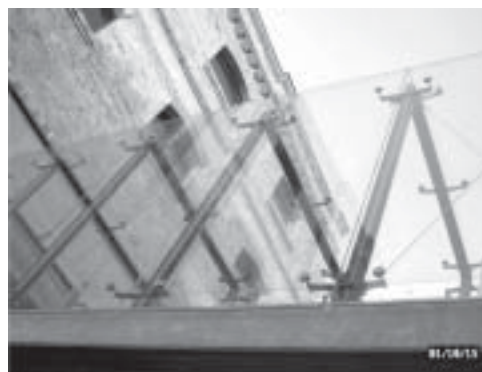
6. ábra. Egyrétegű üveg került az újpesti MEO Galéria hidjaira, így itt kisebb és vékonyabb acélból készült karokat hegeszthettek a csőkeretekre. Üveg: 10 mm vastag
