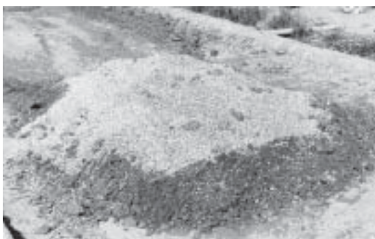
9. ábra. A fűrészpor hozzáadása a szalmával kevert agyaghoz
