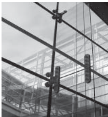
16. ábra. Külföldi példa: üvegoszlop toldása
