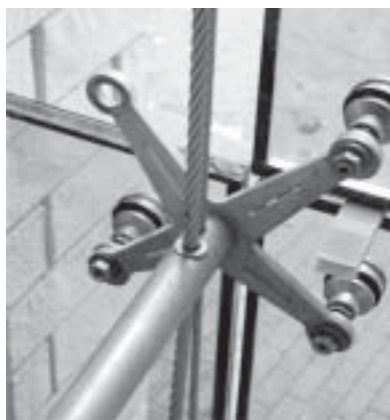
4. ábra. SZEGO pontmegfogó szerelvény merevebb "csillag alakú" típusa
