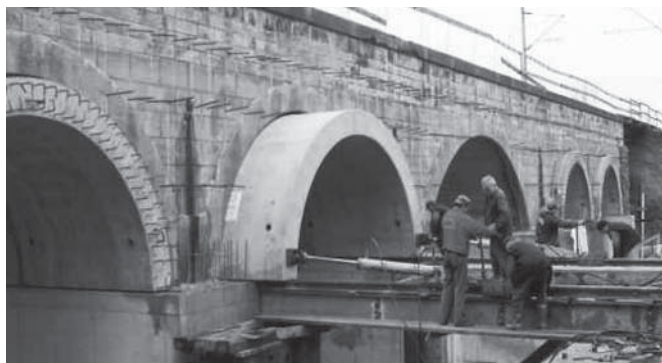
4. ábra Vasúti híd rekonstrukciója előregyártott vasbeton dongaelemekkel Fig. 4. Reconstruction of a railway bridge with precast reinforced concrete shells
