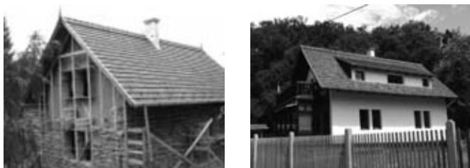
2. ábra Magyarkúti szalmabála hőszigetelésű favázas vályogház (forrás: epiteszforum.hu/node/17347) Fig. 2. Straw bale insulated, timber frame adobe house in Magyarkút
